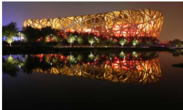
Das sogenannte „Vogelnest“, das für die Olympiade 2008 erbaute Stadion in Abendstimmung. Die statischen Berechnungen für die komplexe Architektur wurden übrigens mit ANSYS durchgeführt. Foto: M. Wünschner
